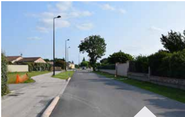
Réalisation des travaux chemin de Bergès
