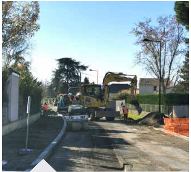
Finalisation des travaux chemin de Bergès.
